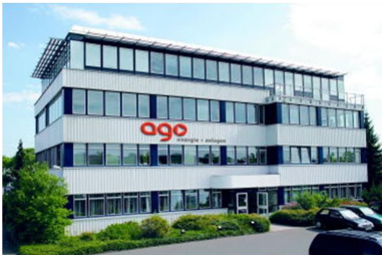
Zentrale von AGO AG Energie + Anlagen in Kulmbach
