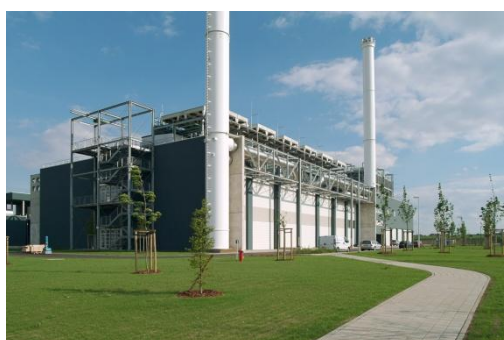
Energieversorgungscenter von AMD in Dresden
