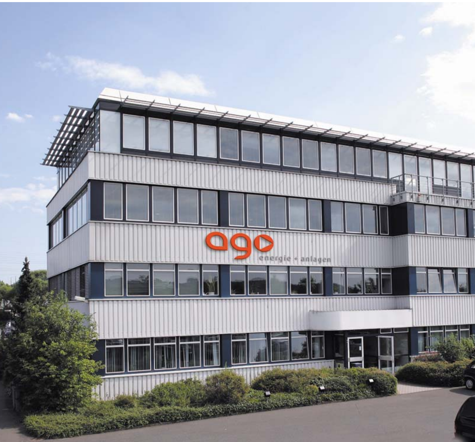
Firmengebäude der AGO AG Energie + Anlagen, Kulmbach
