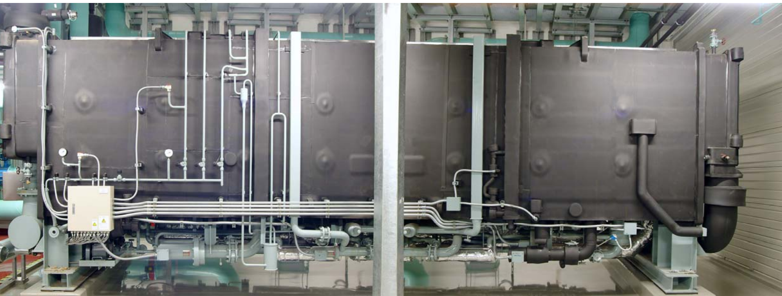
AGO-Absorptionskälteanlage
